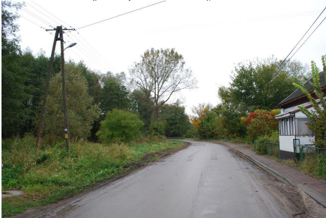
Fotografia 9 Zły stan nawierzchni dróg w Tarlowie
